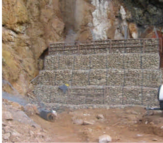
Grand porche identifié comme passage privilégié, avec pose de gabions et chiroptière (entrée verti- cale) Avant-Après
