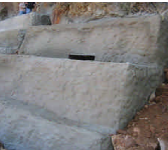
Petit porche mis à jour fermé avec gabions et chiroptière en façade Après
