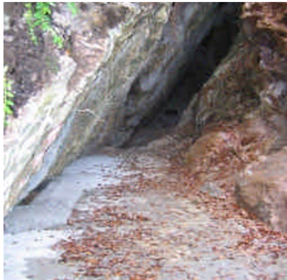
Puits sur versant opposé + galerie dans le fond, pose d'une dalle avec chirop- tère Avant-Après
