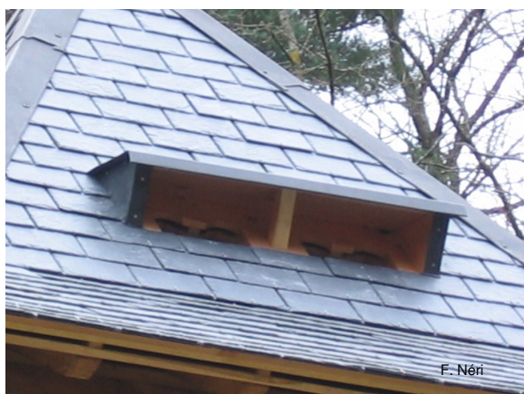
Rénovation d'un pigeonnier dans le Tarn – installation d'une chiroptière
