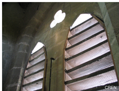
Grillage sur les ouvertures des églises pour lutter contre les pigeons et empêchant les chauves-souris de passer
